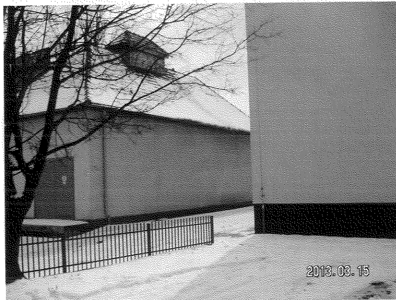
Fot. 5 – Widok budynku stacji transformatorowej usytuowanej w odległości 6 m od budynku byłej stołówki, z którą graniczy ściana oddziolenia przeciwpożarowego o klasie odporności ogniowej REI 120.
