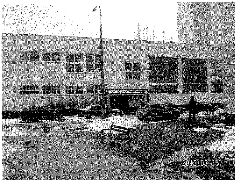
Fot. 1 – Fragment elewacji frontowej z widocznym głównym wejściem do klatki schodowej „D”.
